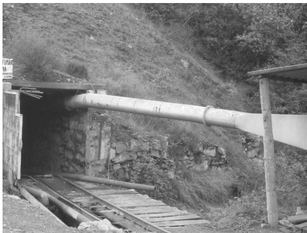
Figura 3. Aspecto de la entrada al socavón de la mina "Roca y Torra" en el año 1990.
